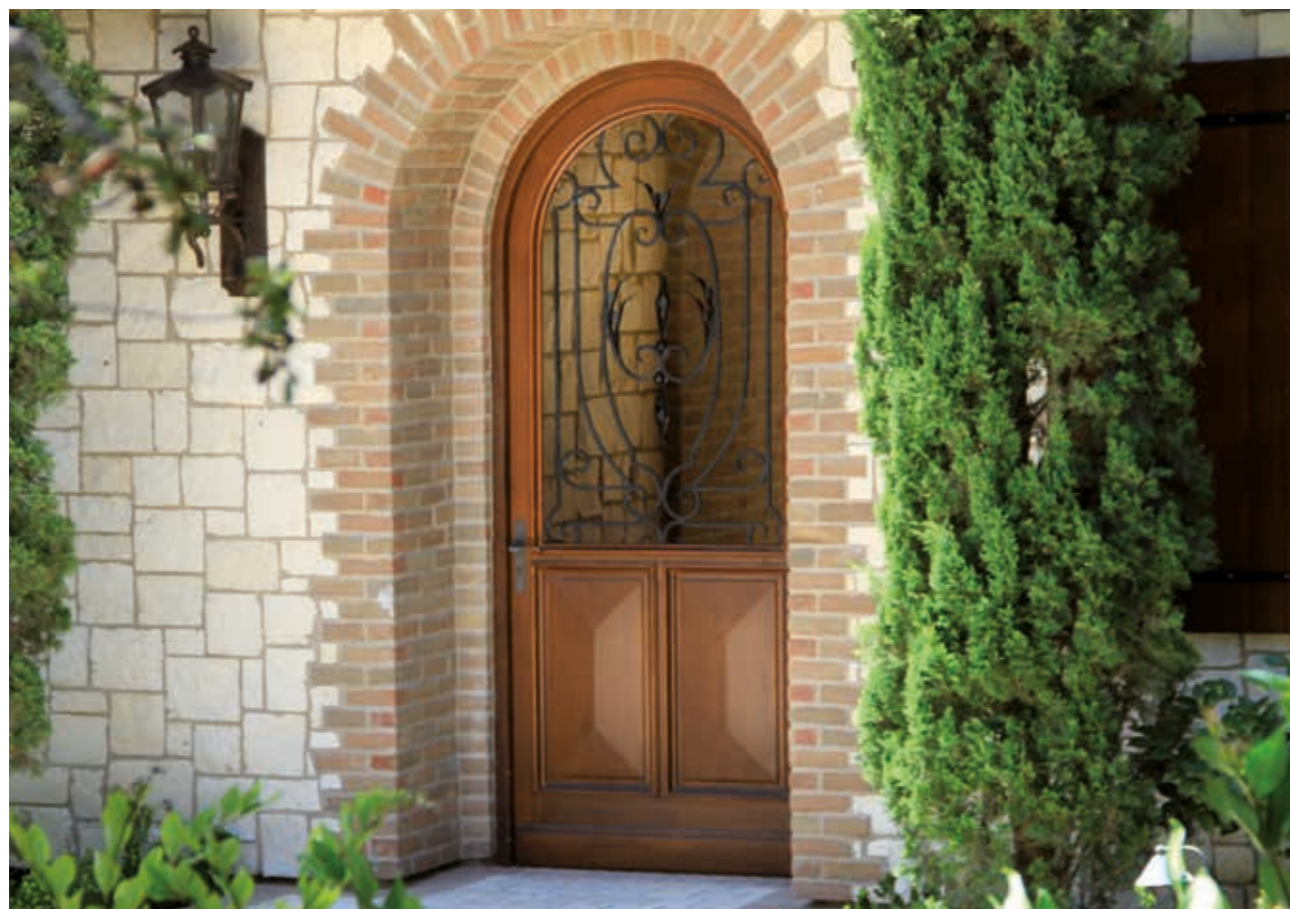
■ Réf. Z16 - Remontage de la grille en fer forgé d'origine
