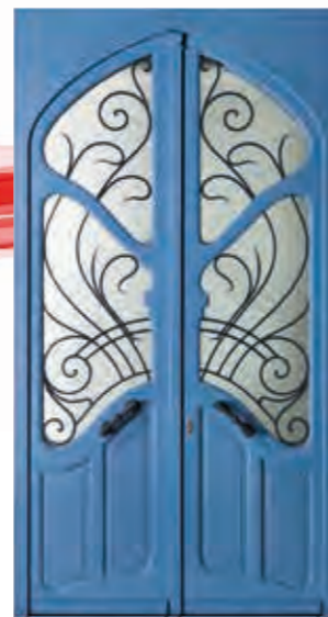
■ Réf. Z15 Remontage de la grille en fer forgé d'origine
